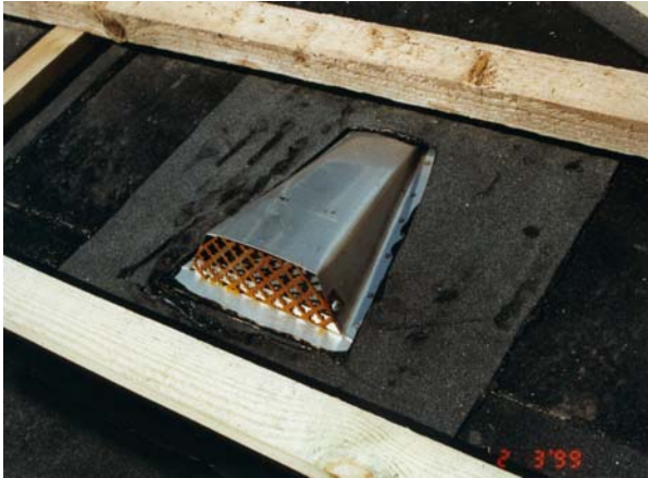
Ventilationsstuds i det faste undertag — en såkaldt fisk.
