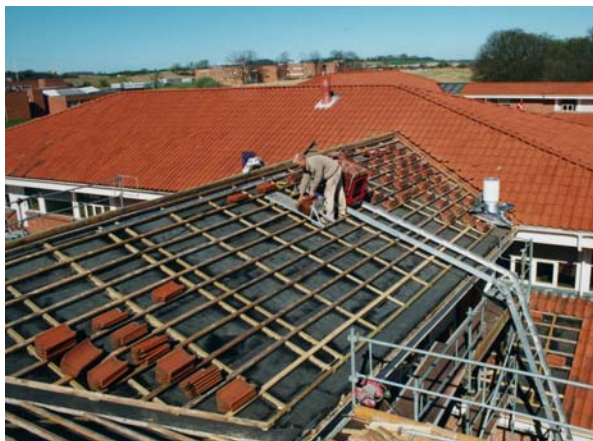
Det faste undertag på den nederste tagflade understøtter stillads for reovering af den øverste tagflade.
